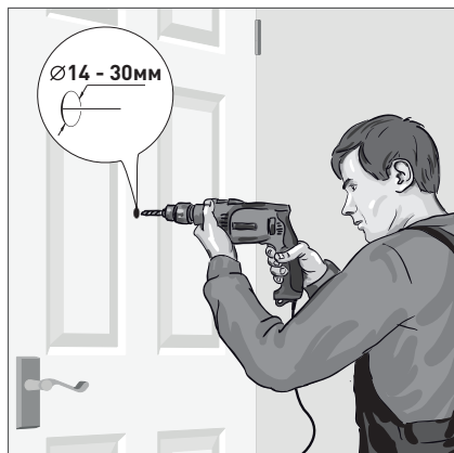
Рис.3. Подготовка отверстия
